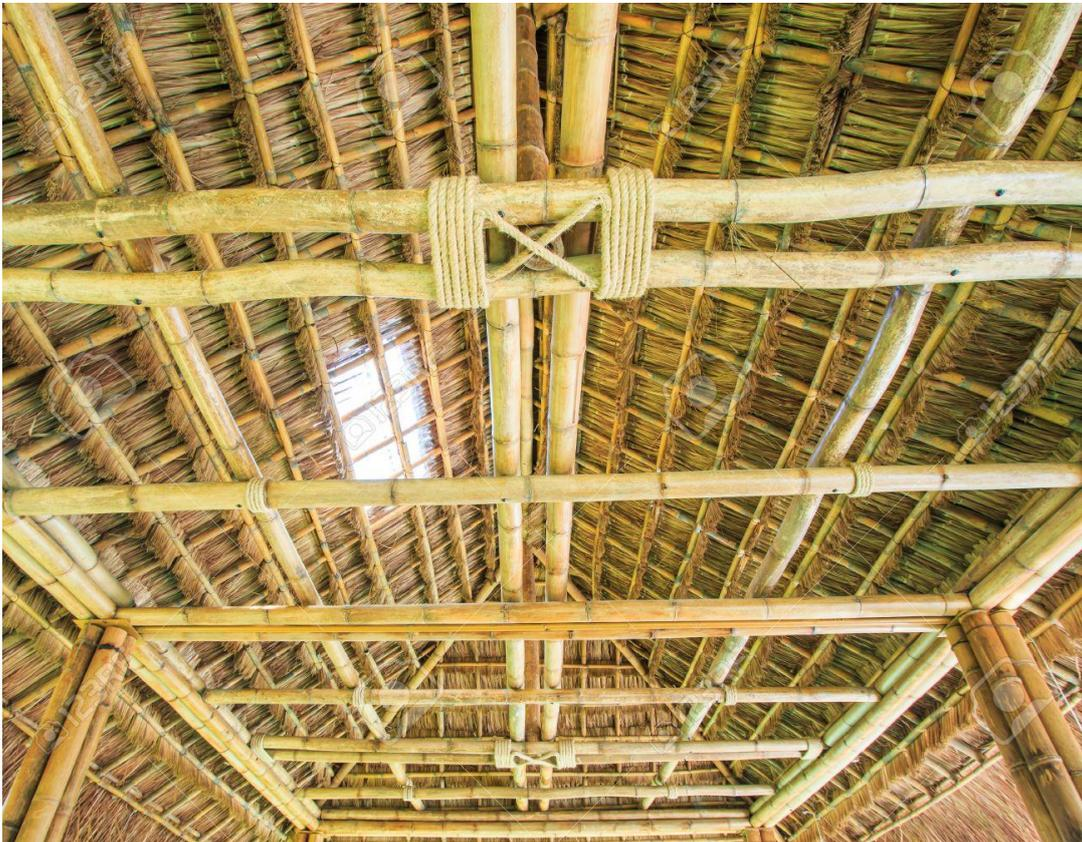
Figure 33 Photo d'une charpente en bambou en Thaïlande (Source : 123RF)
