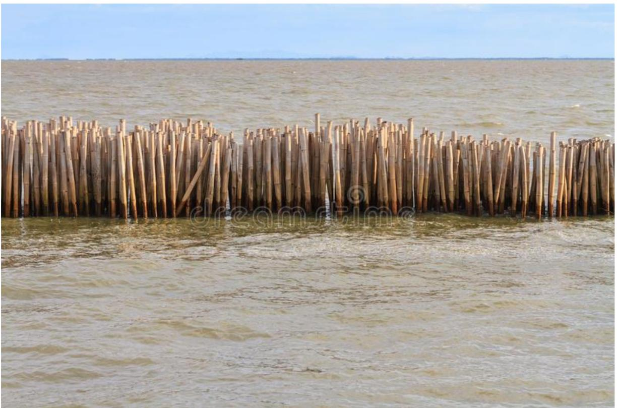
**Figure 25** Photo d'un brise-lame en bambou installé dans la province de Phuket en Thaïlande (Source : Dreamstime)
